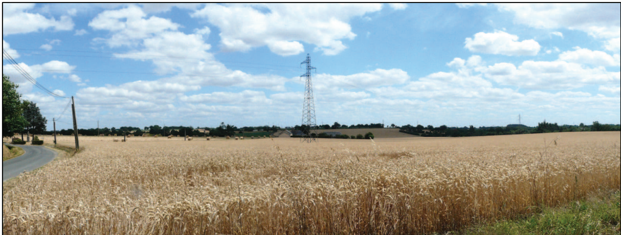
Ligne électrique à Loigné-sur-Mayenne
